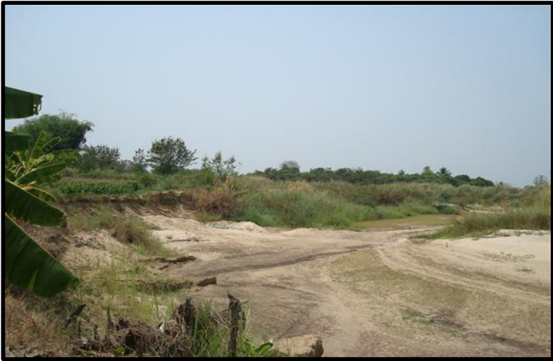
อาคารทดน้ำบ้านตลิ่งสูง
