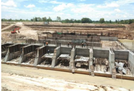
ประตูระบายน้ำ
