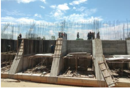
ประตูระบายน้ำ
