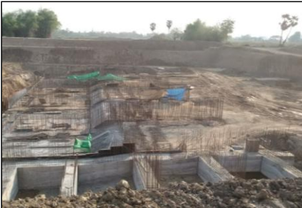
งานคอนกรีตประทุระบายน้ำ
