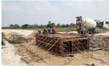
งาน ทรบ.ปากคลองส่งน้ำสาย 1R-LMC
