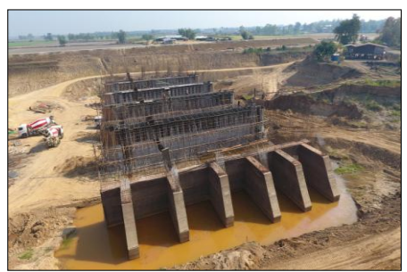
งานประตูปะบายน้ำ
