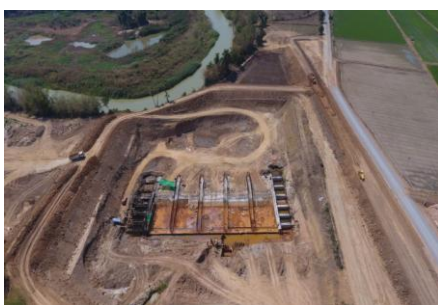
งานประตูละบายน้ำ
