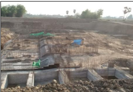
งานคอนกรีตประทุระบายน้ำ
