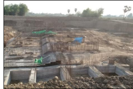
งานคอนกรีตประจวบฯบ้านน้ำ
