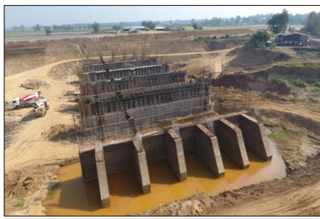
งานประจวบฯบ้านน้ำ
