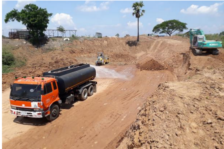
งานดินถมบดอัดแน่นด้วยเครื่องจักรคันประตุระบายน้ำ
