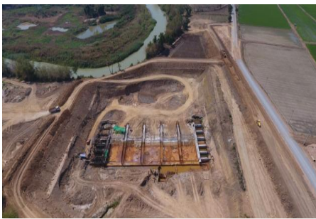
งานประจวบฯบ้านน้ำ
