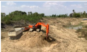
งานขุดดินด้วยเครื่องจักร (ท้ายผายตลิ่งสูง)
