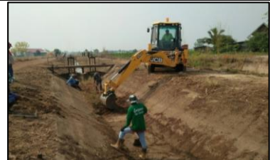
งานชุดลอกตะกอนคลองส่งน้ำ
