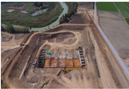
งานประตูระบายน้ำ
