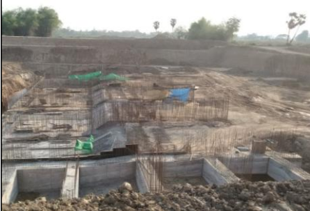
งานคอนกรีตประตูระบายน้ำ
