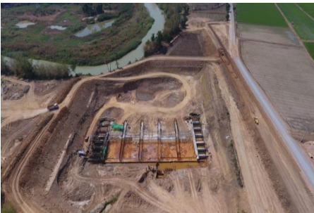
งานประตูระบายน้ำ
