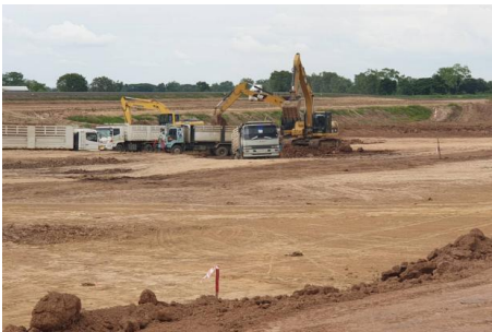
งานขุดบ่อก่อสร้าง (ประตุระบายน้ำ)
