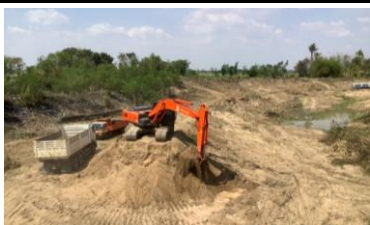
งานขุดดินด้วยเครื่องจักร (ท้ายฝายตลิ่งสูง)
