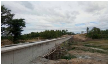
งานสะพานน้ำ
