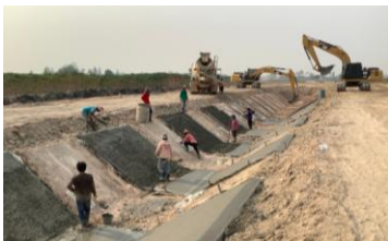
งานลาดคอนกรีตคลองส่งน้ำ (1R-RMC)
