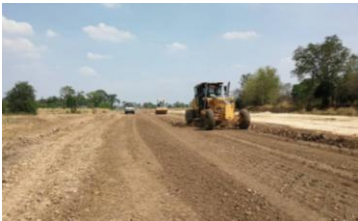
งานดินถมบดอัดแน่นด้วยเครื่อง (1R-LMC)
