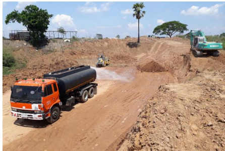
งานดินถมบ่ออัดแน่นด้วยเครื่องจักรคันประตุนะบายน้ำ
