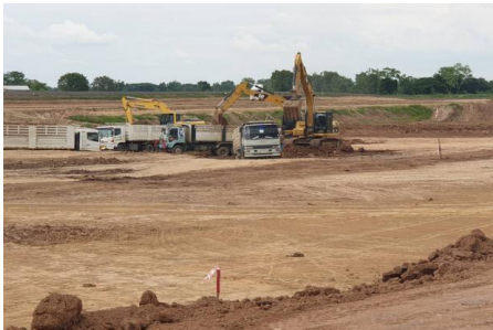
งานขุดบ่อก่อสร้าง (ประตุนะบายน้ำ)
