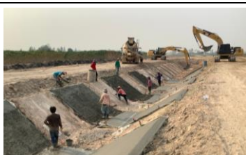
งานคาดคอนกรีตคลองส่งน้ำ (1R-RMC)
