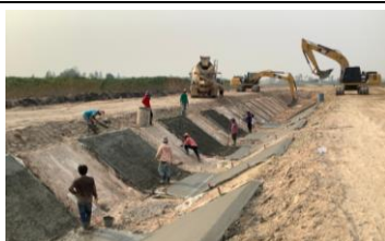
งานขุดลอกและติดตั้งคลองส่งน้ำ (1R-RMC)
