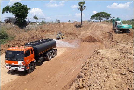
งานดินถมบ่ออัดแน่นด้วยเครื่องจักรคันประตุระบายน้ำ
