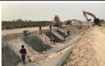
งานดาดคอนกรีตคลองส่งน้ำ (1R-RMC)
