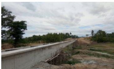
งานสะพานน้ำ
