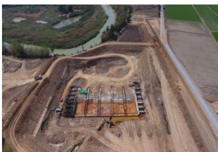
งานประตูปรับน้ำ
