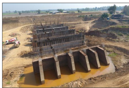
งานประตูปรับน้ำ
