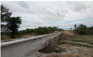
งานสะพานน้ำ
