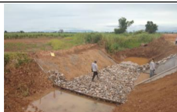
งานหินเรียงท่อดคลองส่งน้ำ กม.10+250 (LMC)
