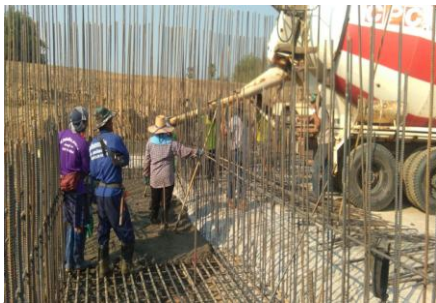
งานเทคอนกรีตพื้นประตูประบายน้ำ
