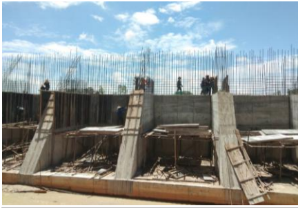
ประตูประบายน้ำ
