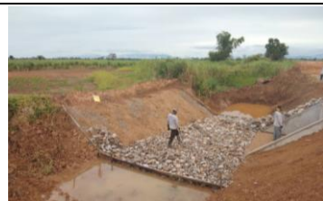
งานหินเรียงทอลอดคลองส่งน้ำ กม.10+250 (LMC)
