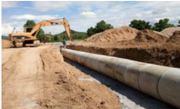
งานท่อลอดคลองส่งน้ำชนิดท่อกลม
