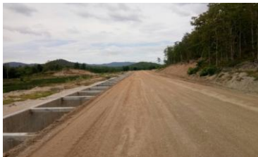
งานรางระบายน้ำ คสล. แบบ U-SHAPE
