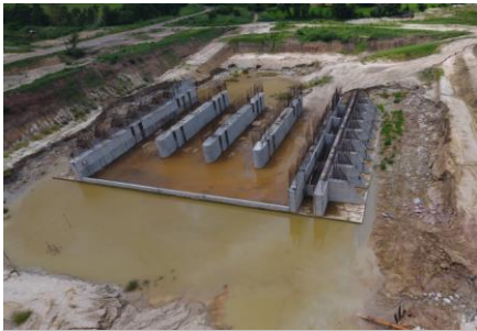
งานประตูประบายน้ำ
