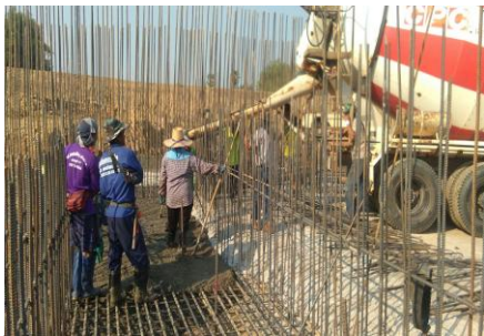
งานเทคอนกรีตพื้นประตูปรับน้ำ
