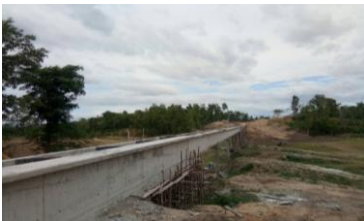
งานสะพานน้ำ
