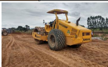
งานดินถมบดอัดแน่นด้วยเครื่อง (LMC)
