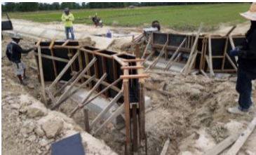
งานสะพานคนข้าม กม.1+730.000 (1L-2R-1L-RMC)
