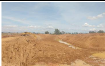
งานชุดคลองระบายสายใหญ่ (MD)
