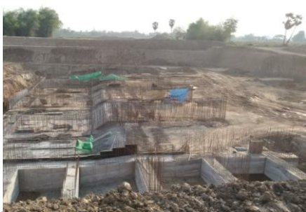
งานคอนกรีตประตูปรับน้ำ
