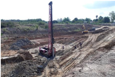
งานเสาเข็ม คอ. (ประตุระบายน้ำ)
