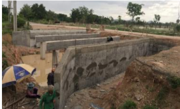
งานสะพานรถยนต์ กม.1+389.000 (D2L-MD3)
