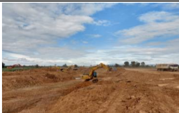
งานขุดคลองระบายสายใหญ่ (MD)
