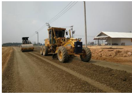
งานชั้นรองพื้นทาง (ถนนทดแทน)
