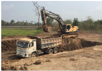
งานขุดบ่อก่อสร้างประตูระบายน้ำ
