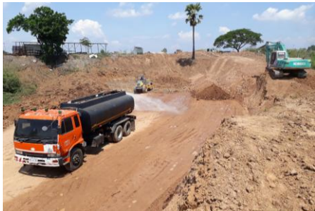
งานดินถมบดอัดแน่นด้วยเครื่องจักรกลประตุระบายน้ำ
