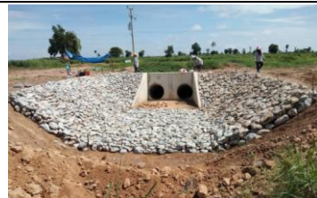
งานหินเรียงทอหลอดคลองส่งน้ำ กม.10+000
