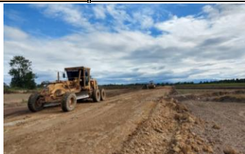
งานดินถมบดอัดแน่นด้วยเครื่อง (2L-1R-LMC)
