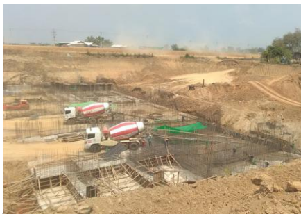
งานเทคอนกรีตพื้นประตุระบายน้ำ
