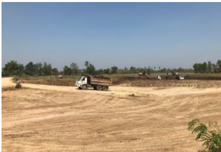
สถานที่ก่อสร้างประตูประบายน้ำท่าแห
