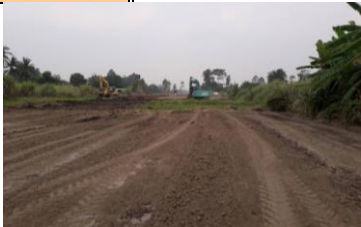
งานขุดเปิดหน้าดินคลองส่งน้ำสาย 1R-LMC
