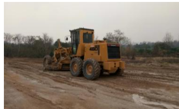
งานดินถมบดอัดแน่นด้วยเครื่องจักร
