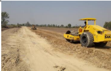
งานดินถมบดอัดแน่นด้วยเครื่องจักร (3L-1R-LMC)
