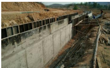
งานรางระบายน้ำ คล.แบบ U-SHAPE
