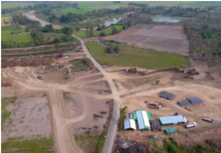
งานขุดบ่อก่อสร้างประตูประบายน้ำ
