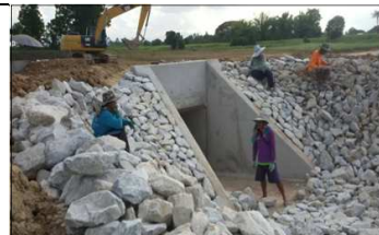
งานท่อลอดคลองส่งน้ำ กม.4+880 (LMC)
