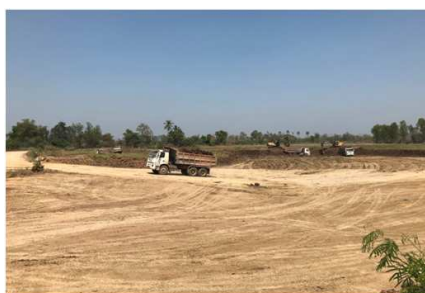
สถานที่ก่อสร้างประตุระบายน้ำท่าแห
