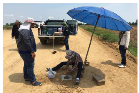
ทดสอบความแน่นชั้นวัสดุคัดเลือก ข งานถนนทดแทน
