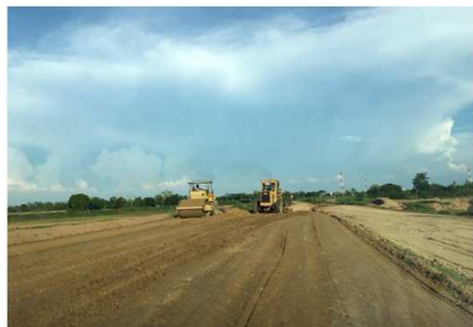
งานก่อสร้างถนนทดแทน
