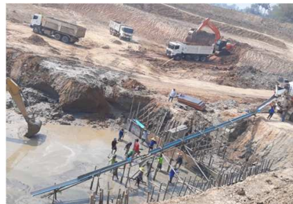
เตรียมงานพื้นประตุระบายน้ำ
