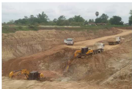
งานขุดดินด้วยเครื่องจักร(บ่อก่อสร้าง)
