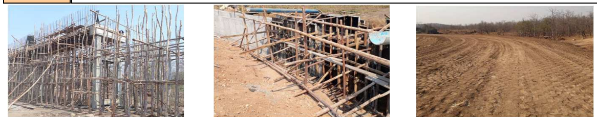
งานสะพานน้ำ | งานรางระบายน้ำ คสล.แบบ U-SHAPE | งานดินถมบดอัดแน่นด้วยเครื่องจักร
