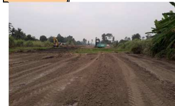
งานขุดเปิดหน้าดินคลองส่งน้ำสาย 1R-LMC
