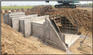
งานท่อลอด คสล. ขนาด 2-[ ] 1.20x1.50 ม.กม.2+955 (คลองแค้น)
