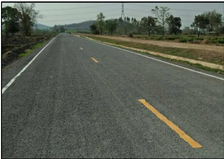
งานผิวทางแบบเบรคเฟสที่ติดตั้ง (1L-RMC)
