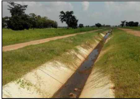
คลองส่งน้ำสาย RMC
