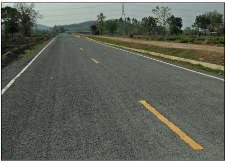
งานผิวทางแบบแอสฟัลต์คอนกรีตสองชั้น (1L-RMC)
