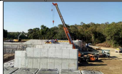
งานติดตั้งคานสะพาน PLANK GIRDER
