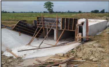
ท่อลอดถนน (BOX CULVERT) กม.4+468.50 (RMC)
