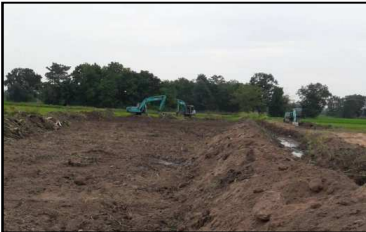
งานขุดเปิดหน้าดิน คลองส่งน้ำสาย 1R-4R-LMC
