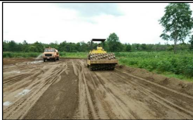
งานดินถมบดอัดแน่นด้วยเครื่องจักร 95%
