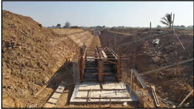
งานท่อลอด คล.ก.ม.0+204 ขนาด 2-[ ] 1.20x1.50 ม.
