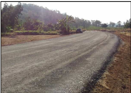
งานหินคลุกบดอัดแน่น คลองส่งน้ำสาย 1L-RMC
