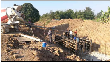
งานท่อลอด คล.ก.ม.0+087 ขนาด 2-[ ] 1.20x1.50 ม.
