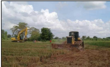
งานขุดเปิดหน้าดิน คลองส่งน้ำสาย 5R-LMC
