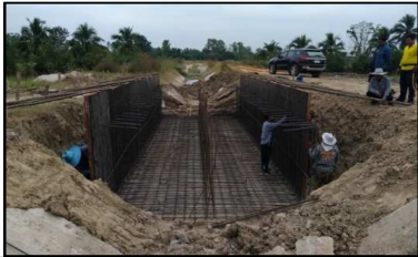
ท่อลอดถนน (BOX CULVERT) กม.5+400 (RMC)
