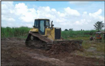
งานขุดเปิดหน้าดิน คลองส่งน้ำสาย LMC
