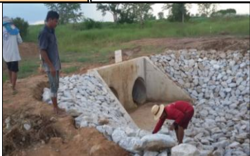
งานท่อลอดคลองส่งน้ำ กม.10+000 (LMC)
