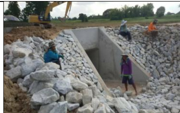
งานท่อลอดคลองส่งน้ำ กม.4+880 (LMC)
