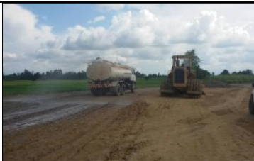
งานดินถมบดอัดแน่นด้วยเครื่องจักร 95% (LMC) กม.6+000
