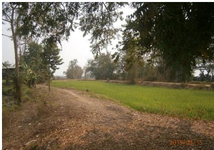
บริเวณบ่อก่อสร้างประตุระบายน้ำ
