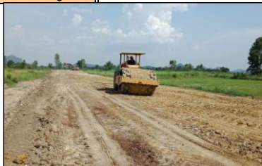
งานดินถมบดอัดแน่นด้วยเครื่องจักร (RMC) กม.7+000
