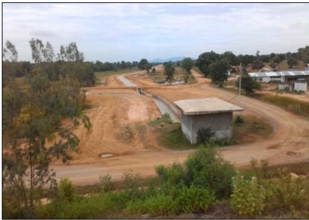
งานร่างน้าด้านท้ายอาคารควบคุมการระบาย
