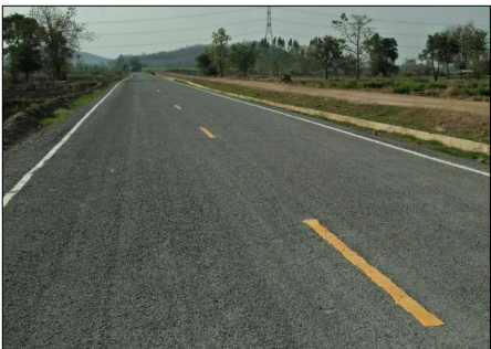
งานผิวทางแบบเซอร่ฟอสฟอริตเมนต์สองชั้น (1L-RMC)
