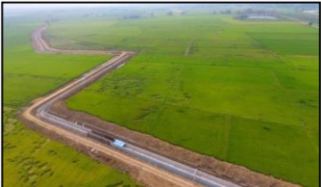
งาน U-SHAPE คลองแค้น กม.1+536.75 ถึง กม.2+948
