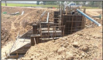
งาน ทบ.ท่อเหลี่ยมเบี่ยงซ้าย ขนาด 2-[ ] 2.00x2.00 ม.
