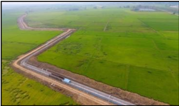
งาน U-SHAPE คลองแค้น กม.1+536.75 ถึง กม.2+948
