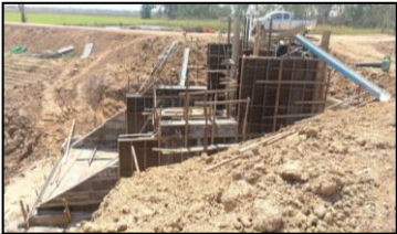
งาน ทบ.ท่อเหลี่ยมบึงอ้ายจิด ขนาด 2-1 2.00x2.00 ม.
