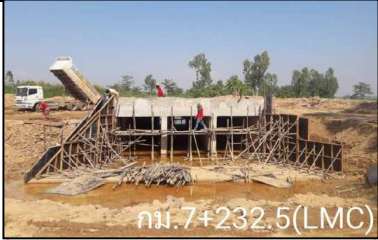
งานท่อลอดคลองส่งน้ำ กม.7+232.5 (LMC)
