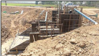
งาน ทรบ.ท่อเหลี่ยมบึงอ้ายจิด ขนาด 2-[ ] 2.00x2.00 ม.
