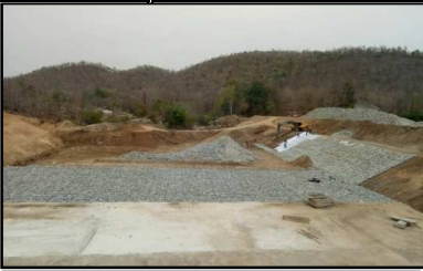
งานประกอบและตั้ง GABIONS
