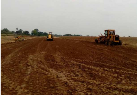
งานดินถมบดอัดแน่นด้วยเครื่องจักร
