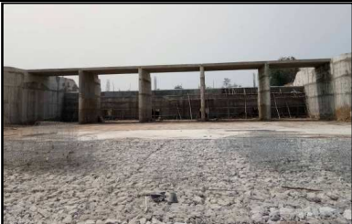
งานติดตั้งคานสะพาน PLANK GIRDER
