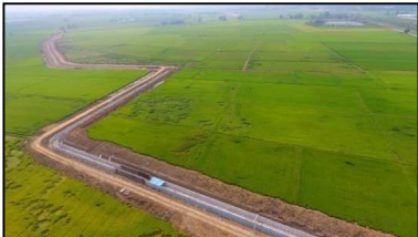
งาน U-SHAPE คลองแท่น กม.1+536.75 ถึง กม.2+948
