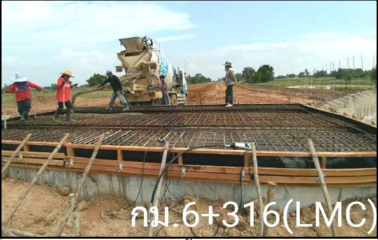
งานท่อลอดคลองส่งน้ำ กม.6+316 (LMC)
