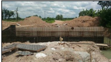
งานสะพานรถยนต์ถนนเข้าหัวงาน กม.0+170
