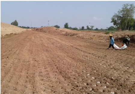
งานดินถมบ่ออัดแน่นด้วยเครื่องจักร
