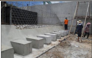
งานฝายคอนกรีตเสริมเหล็ก
