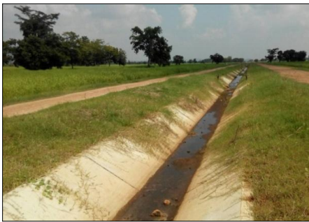
คลองส่งน้ำสาย RMC
