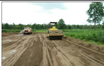
งานดินถมบดอัดแน่นด้วยเครื่องจักร 95%
