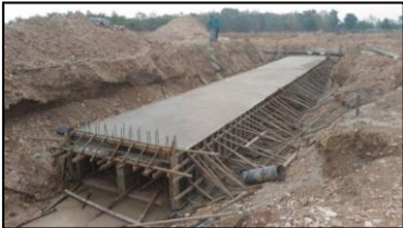
ท่อลอดถนนพร้อมรางน้ำ กม.0+070 (1R-RMC)
