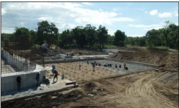
งานพื้นที่คอนกรีตเสริมเหล็ก
