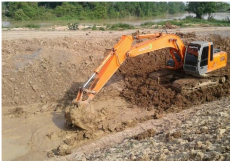
งานขุดดินด้วยเครื่องจักร(บ่อก่อสร้าง)
