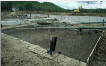
งานพื้นที่คอนกรีตเสริมเหล็ก
