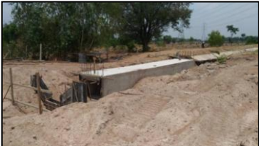
ท่อลอดถนนชนิดท่อเหลี่ยม กม.8+300 (1R-RMC)
