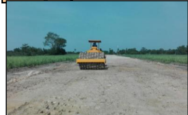
งานดินถมบดอัดแน่นด้วยเครื่องจักร 95% (1L-RMC)
