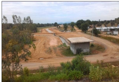
งานรื้อถอนคันดินท้ายอาคารควบคุมการระบาย
