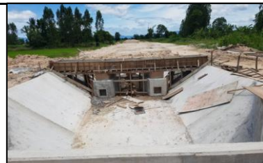
งานท่อลอดถนนหน้า กม.1+461
