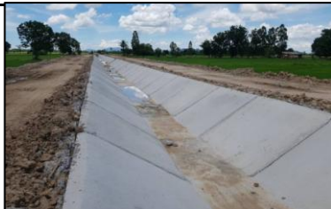
งานคอนกรีตตาดคลองส่งน้ำสาย 1L-RMC
