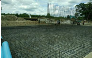
งานฟื้นฟูคนกรรตเสริมเหล็ก
