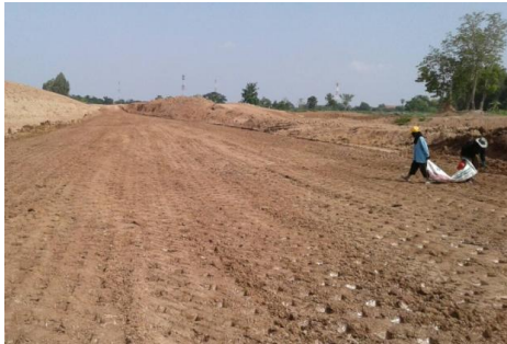
งานดินถมบดอัดแน่นด้วยเครื่องจักร
