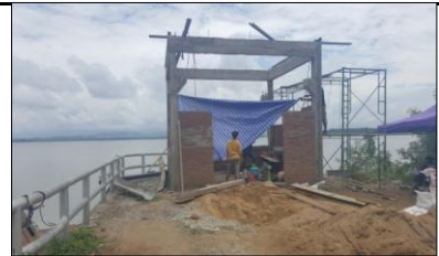
งานอาคารควบคุม (Control House)
