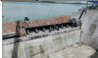
งานติดตั้งบานระบายแบบฝายพับได้
