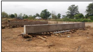
งานสะพานรถยนต์ กม.2+316 (1L-RMC)
