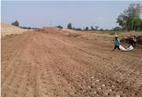
งานดินถมบ่ออัดแน่นด้วยเครื่องจักร
