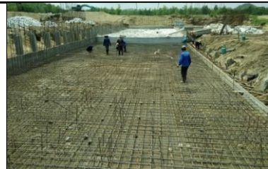
งานพื้นคอนกรีตเสริมเหล็ก
