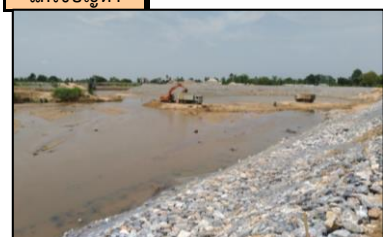
งานปรับปรุงด้านเหนืออาคารทดน้ำฝายบ้านตลิ่งสูง
