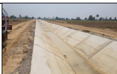
งานคอนกรีตดาดคลองส่งน้ำสาย 11-BMC
