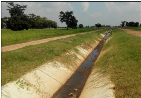
คลองส่งน้ำสาย RMC
