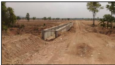
สะพานน้ำ กม.2+817 ถึง กม.2+873 (1R-RMC)
