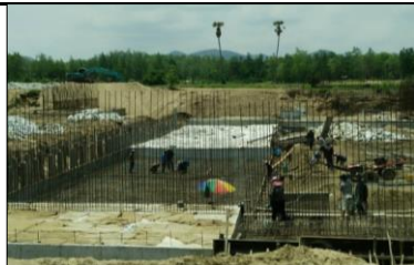
งานฟื้นคอนกรีตเสริมเหล็ก
