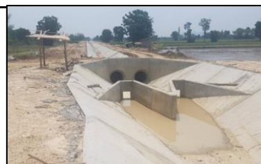
งานท่อลอดถนนทดน้ำ กม 1+461
