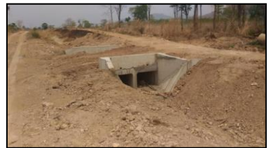
ทางระบายน้ำฉุกเฉิน กม.1+548 (1R-RMC)
