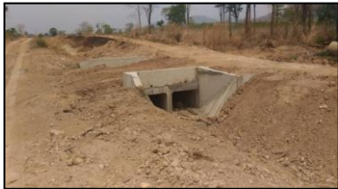
ทางระบายน้ำฉุกเฉินฯ กม.1+548 (1R-RMC)
