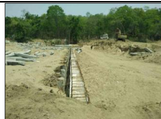
งานศิษย์คอนกรีตเสริมเหล็ก
