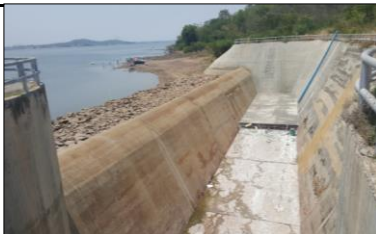
งานเทศนกริตพื้นอาคารทางระบายน้ำล้น
