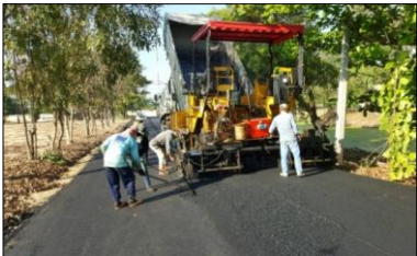
งานปู Asphaltic Concrete หนา 0.05 ม.
