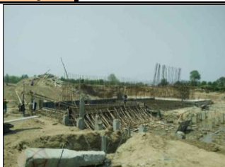
งานพื้นคอนกรีตเสริมเหล็ก
