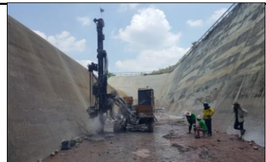
งานเจาะหลุม Anchor Bar
