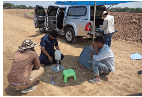
งานทดสอบดินถมบดอัดแน่นด้วยเครื่องจักร
