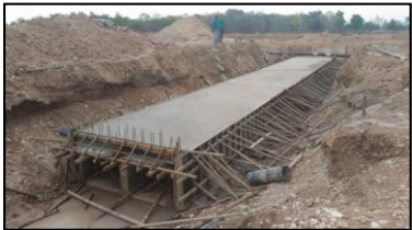
ท่อลอดถนนพร้อมรางฯ กม.0+070 (1R-RMC)
