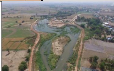
ด้านเหนือหน้าอาคารทอดน้ำฝายบ้านตลิ่งสูง
