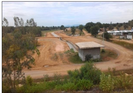
งานรื้อถอนด้านท้ายอาคารควบคุมการระบาย
