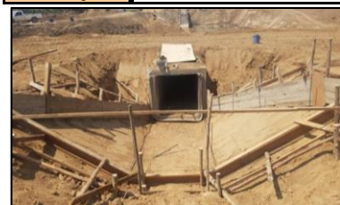
งานไซฟอน กม.4+820.05คลองส่งน้ำสาย 1L-RMC
