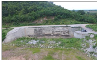
อาคารทางระบายน้ำล้น
