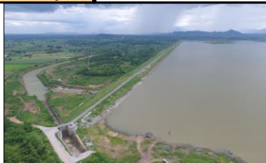
อ่างเก็บน้ำคลองโพธิ์
