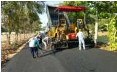
งานปู Asphaltic Concrete หนา 0.05 ม.
