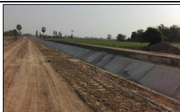
งานคอนกรีตตาดคลอง กม.0+200 ถึง กม.0+440
