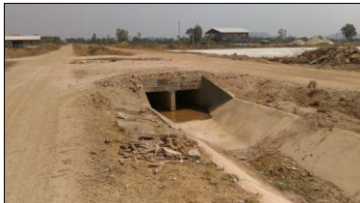
ท่อลอดถนนชนิดท่อเหลี่ยม กม.4+750 (RMC)
