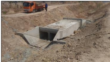
ท่อลอดถนนชนิดท่อเหลี่ยมพร้อมรางระบายน้ำ (1R-RMC)
