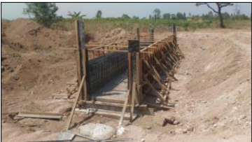
อาคารสะพานน้ำ กม.8+127-กม.8+143 (1R-RMC)
