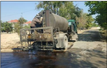
งาน Tack Coat
