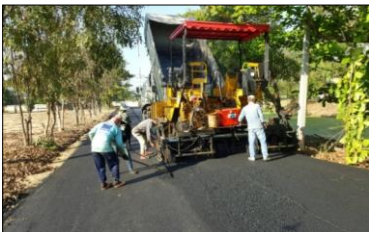
งาน Asphaltic Concrete หนา 0.05 ม.
