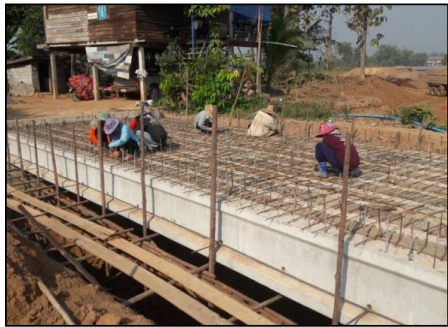
กิจกรรมสะพานรถยนต์ กว้าง 6 ม. กม.0+290
