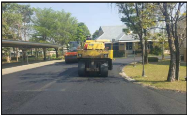
งานบดอัดผิวทางแบบ Asphaltic Concrete
