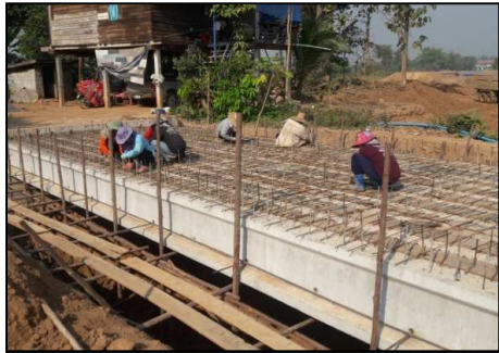
กิจกรรมสะพานรถยนต์ กว้าง 6 ม. กม.0+290
