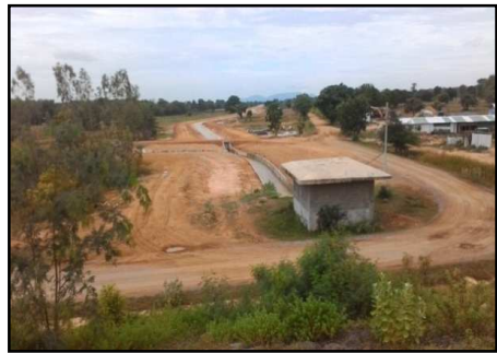
งานรื้อถอนอาคารควบคุมการระบายน้ำ
