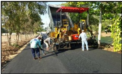
งานปู Asphaltic Concrete ทน 0.05 ม.
