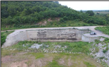
อาคารทางระบายน้ำล้น
