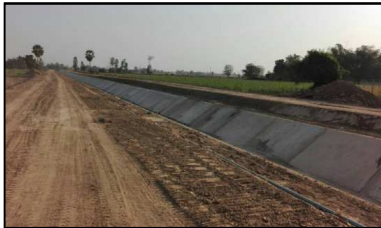
งานคอนกรีตดาดคลอง กม.0+200 ถึง กม.0+440
