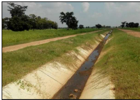
คลองส่งน้ำสาย RMC
