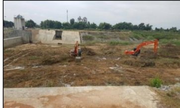
งานดินชุดด้วยเครื่องจักรด้านเหนือน้ำ
