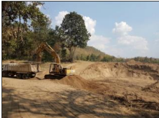
งานขุดเปิดหน้าดิน
