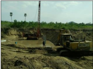
งานตอกเสาเข็มคอนกรีตอัดแรง
