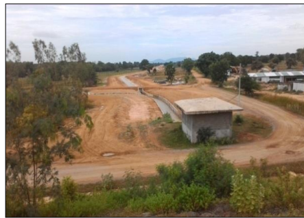
งานรณน้ำด้านท้ายอาคารควบคุมการระบาย
