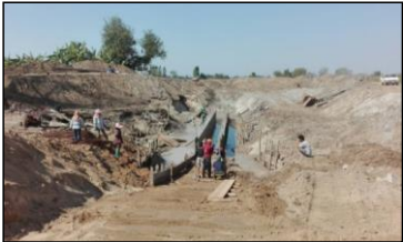
งานขุดลอก กม.4+820.05คลองส่งน้ำสาย 1L-RMC
