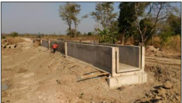
อาคารสะพานน้ำ กม.2+817 - กม.2+873 (1R-RMC)
