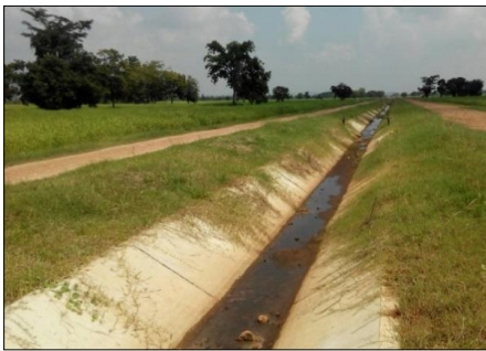
คลองส่งน้ำสาย RMC
