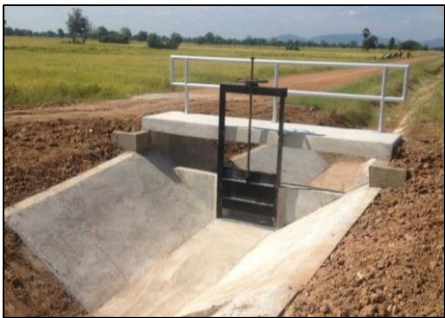
คลองส่งน้ำสาย RMC กม. 2+300 – กม. 2+500
