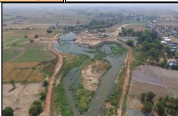
ด้านเหนืออาคารทดน้ำฝายบ้านตลิ่งสูง
