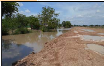
คลองส่งน้ำสาย RMC
