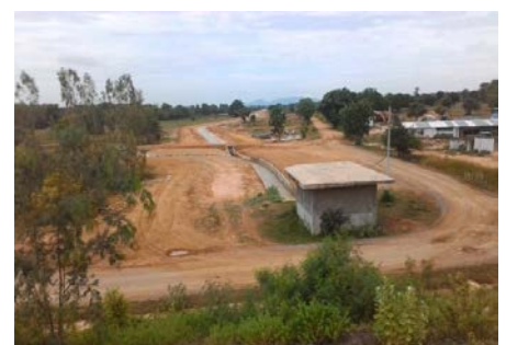
งานรื้อถอนอาคารควบคุมการระบาย
