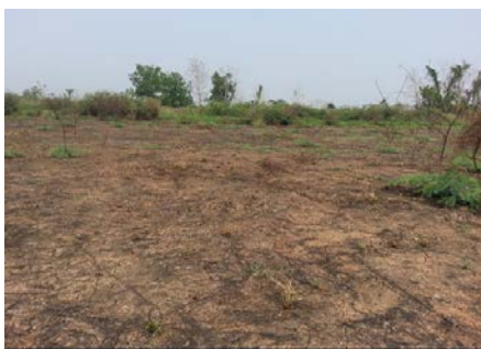
บริเวณจุดก่อสร้าง ใน Cut Off
