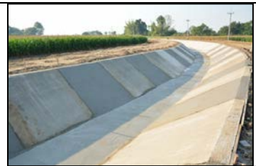
งานดาดคอนกรีตคลองส่งน้ำสาย RMC
