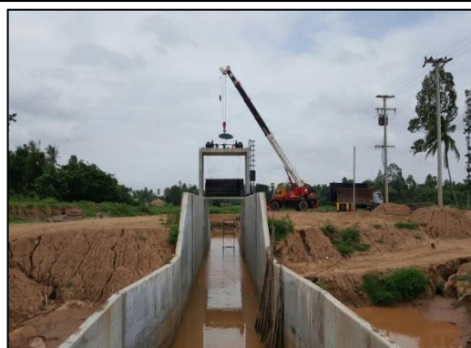
กิจกรรมก่อสร้าง ประตูคลองชักน้ำแม่น้ำน่าน-คลองอ้ายคก
