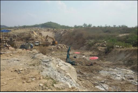
งานปรับปรุงฐานรากบริเวณร่องแฉกเขื่อนหลัก
