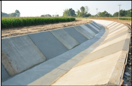
งานติดตั้งคอนกรีตคลองส่งน้ำสาย RMC
