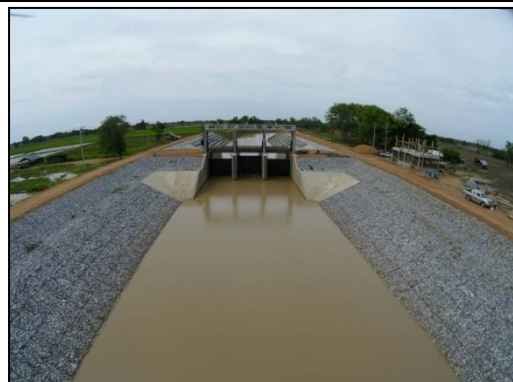
กิจกรรมก่อสร้าง ประตูทุ่งป่ากระถิ่น
