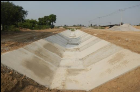
งานติดตั้งคอนกรีตคลองส่งน้ำสาย RMC
