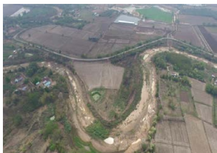
บริเวณจุดก่อสร้าง ใน Cut Off
