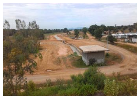
งานรณงน้ำด้านท้ยอาคารควบคุมการระบาย
