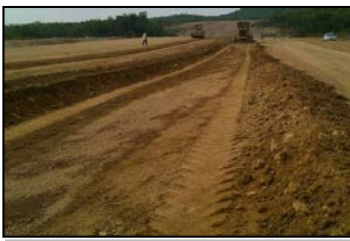
ดินถมบดอัดแน่นตัวเขื่อน กม.1+250 ถึง 1+500
