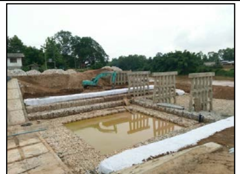
กิจกรรมสะพานรถยนต์ กม.5+793
