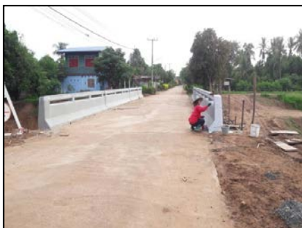
กิจกรรมก่อสร้างสะพานรถยนต์ กม.0+290
