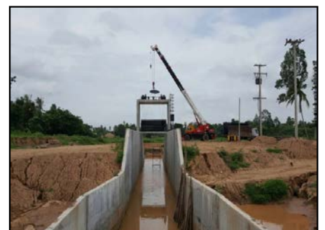
กิจกรรมก่อสร้าง ประตูคลองชักน้ำแม่น้ำน่าน-คลองอ้ายคก
