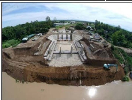
กิจกรรมประตูระบายน้ำ กม.5+731.50
