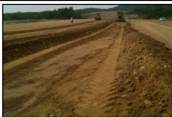
ดินถมบดอัดแน่นตัวเขื่อน กม.1+250 ถึง 1+500
