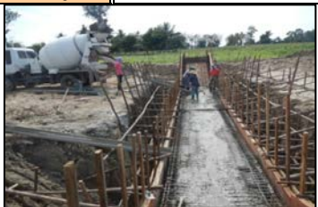
งานท่อลอดคลองส่งน้ำสาย RMC กม.1+460
