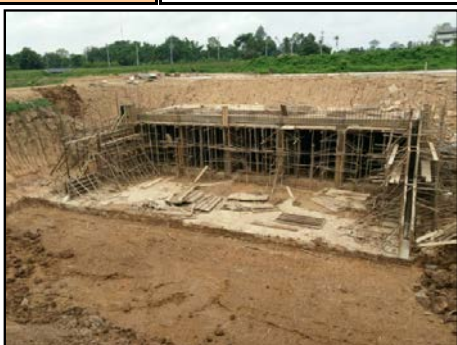
กิจกรรมท่อลอด กม.5+232
