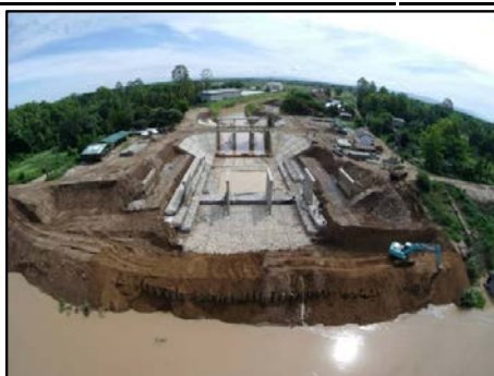
กิจกรรมประตูระบายน้ำ กม.5+731.50
