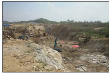
งานปรับปรุงฐานรากบริเวณร่องแกนเขื่อนหลัก
