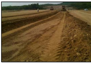
ดินถมบดอัดแน่นตัวเขื่อน กม.1+250 ถึง 1+500
